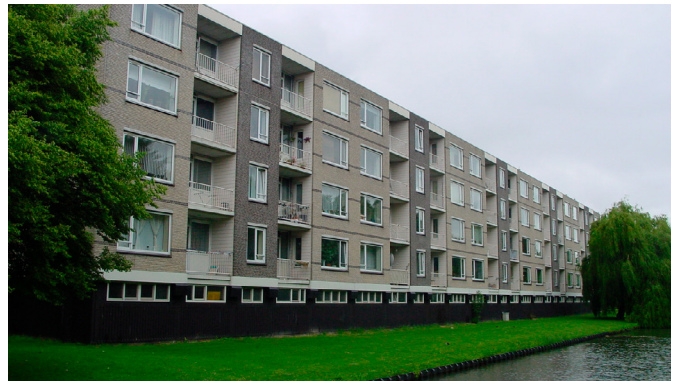
In het ketelhuis van het appartementencomplex in Rozenburg met 25 woningen worden de eerste waterstofketels in Nederland geïnstalleerd.
