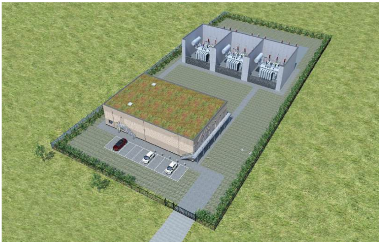
Figuur 4: impressie typisch 150/21kV hoogspanningsstation
