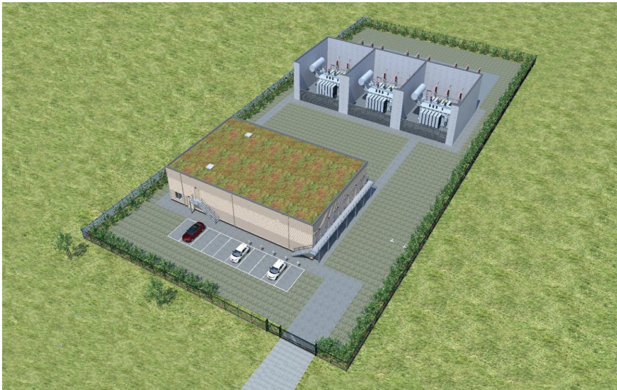
Figuur 4: impressie typisch 150/21kV hoogspanningsstation
