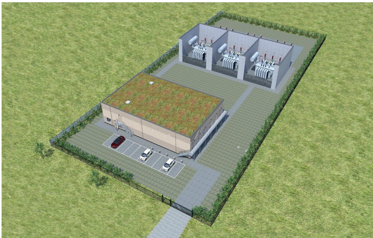
Figuur 4: impressie typisch 150/21kV hoogspanningsstation
