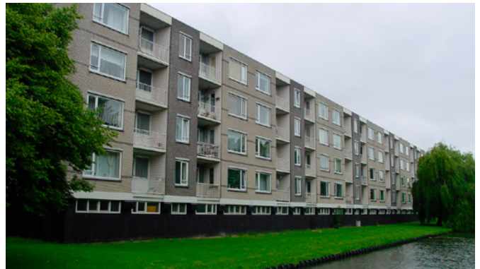
In het ketelhuis van het appartementencomplex in Rozenburg met 25 woningen worden de eerste waterstofketels in Nederland geïnstalleerd.
